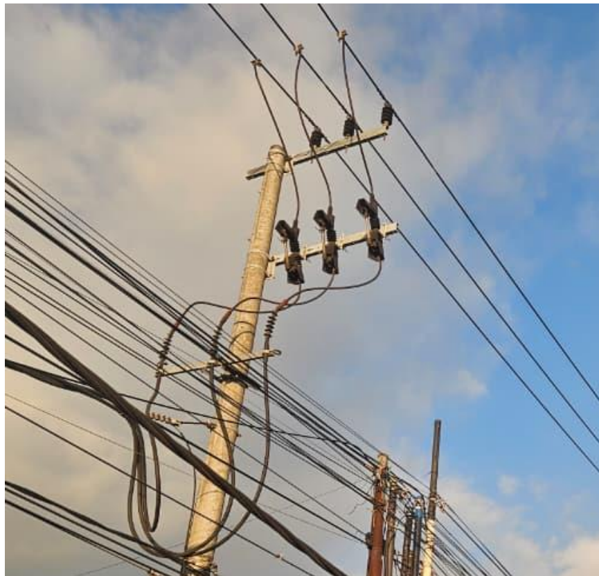
GAMBAR 3. PEMASANGAN TEKEP ISOLATOR FCO DI PERCABANGAN/SECTION
