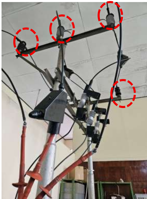
GAMBAR 6 PEMASANGAN TEKEP ISOLATOR UNTUK GARDU PORTAL AAC 70 MM 2
