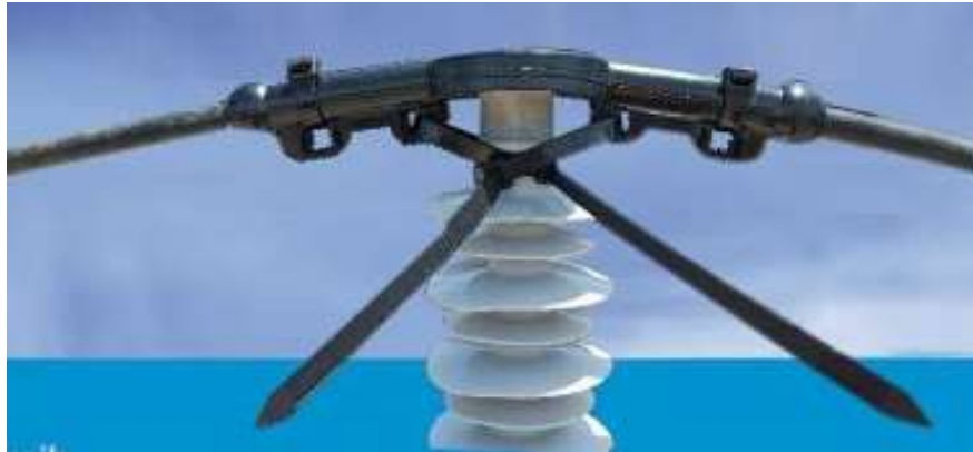
GAMBAR 5 PEMASANGAN TEKEP ISOLATOR UNTUK JARINGAN SUTM LURUS AACS 240 MM2
